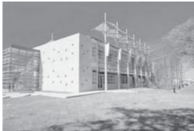
Figura 3. Diseño sustentable en edificios: Diseño bio-climático como parte del Diseño sustentable; específicamente de cubiertas suspendidas, lo cual sirve para el sombreado interno y externo de los espacios arquitectónicos. (Fuente: Schwarz, Edward. Office building in Costa Rica , pp. 42; Holcim Foundation, Suiza, 2006).
