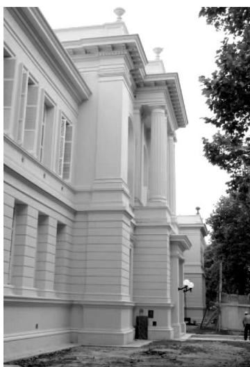
Fachada sobre diagonal 77 2001-2004
