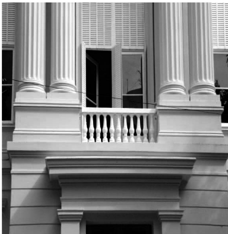
Reposición de piezas faltantes y restauración de la balastrada
