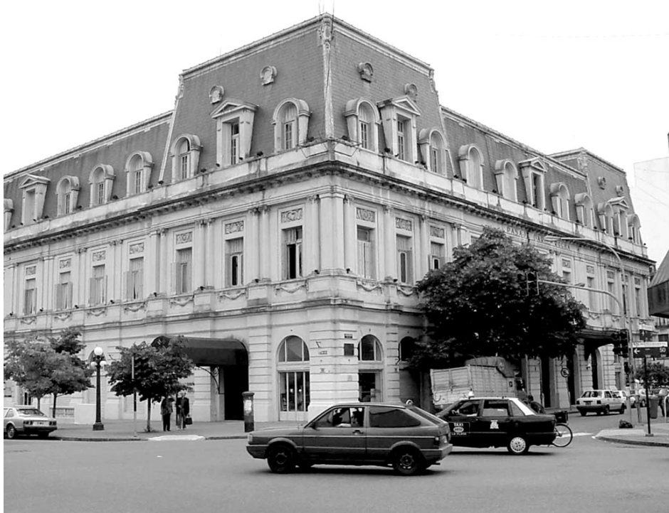
Pasaje Dardo Rocha. Vista desde calle 6
