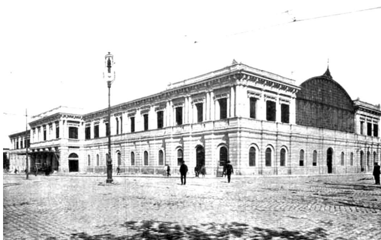
Pasaje Dardo Rocha. Vista desde calle 6
