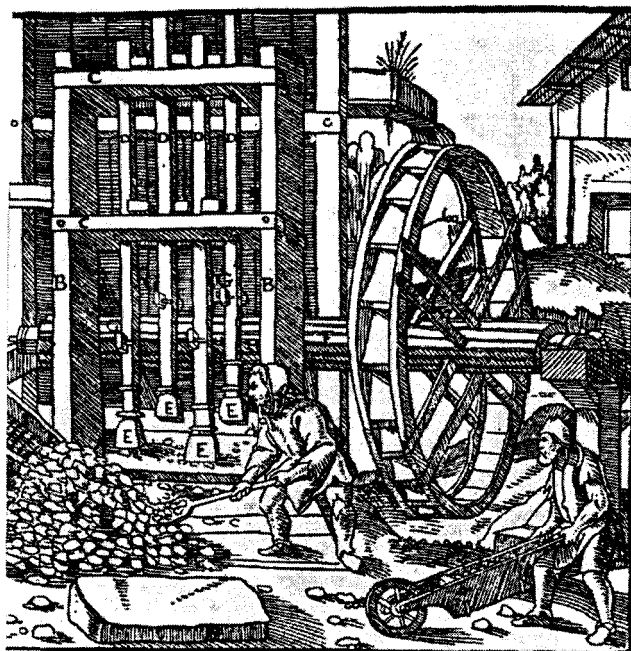
Fig. 3. Molino hidráulico que muestra el dispositivo de mazos empleado en la molienda del mineral en las minas alemanas del siglo XVI. Obsérvese la caída de agua en la parte superior. Grabado tomado de De re metallica de Georgius Agrícola.
