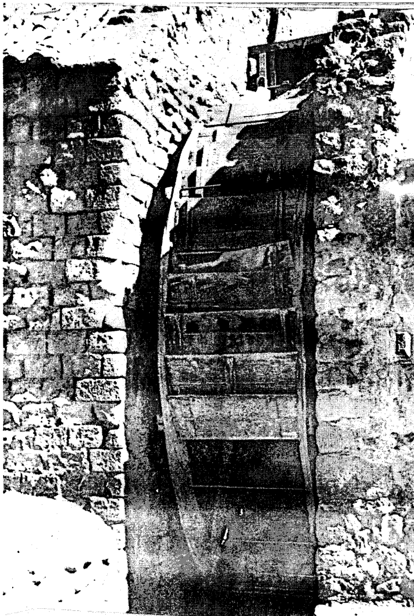
Fig.2. Fotografía de la rueda de un molino hidráulico de Potosí, inserta entre las dos paredes de su cárcamo o castillo. Se aprecian las paletas acajonadas y, en la parte superior, el vertedero del agua que impulsaba la rueda y su eje central, observable en la siguiente figura.
