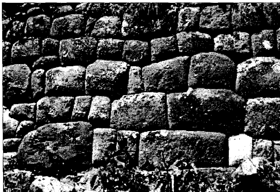
Foto 5: Detalle de los litos poligonales de diversos pesos, tamaños y formas, ensamblados para conformar el muro frontal de la Portada Trapezoidal.
