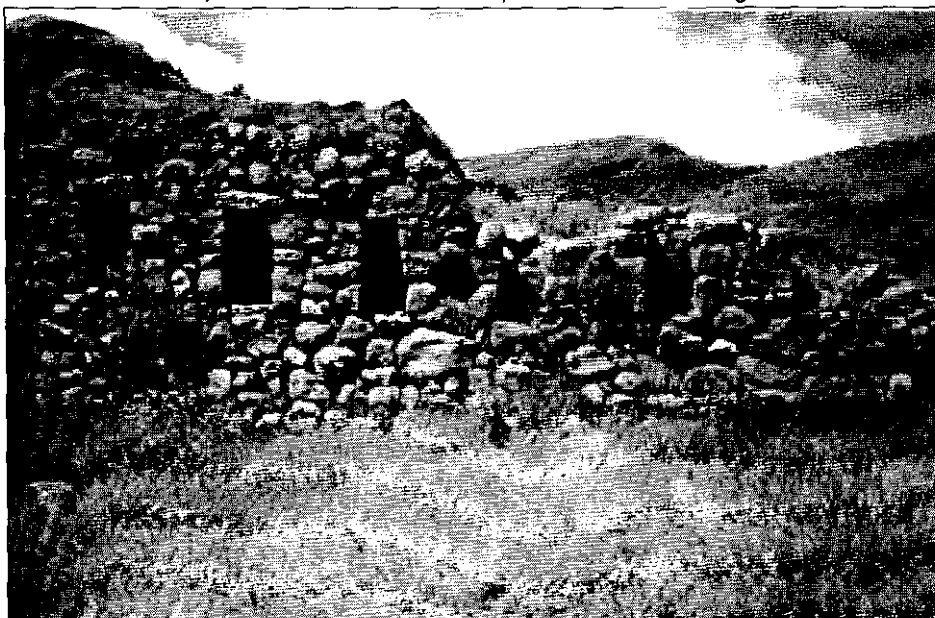
Foto 2: Sección del muro este del cuadrángulo de los nichos conservando algunos completos y otros desplomados.
