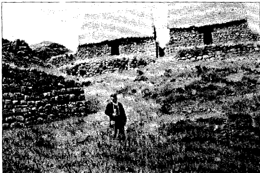
Foto 3: Vista frontal de las dos casas con techos restaurados. Ver la separación con un gran vano trapezoidal de doble jamba construido en base a piedras labradas finas.
