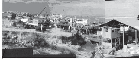
La "Costa Brava" socava el margen izquierdo; la Bomba de agua se moviliza en función a la corriente del río
