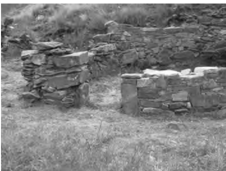
26. Vista de entrada al Recinto 1. Nótese la diferencia entre el muro de la izquierda (original) y el muro de la derecha (restituido).
