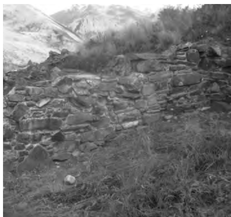
7. Paramento de interior de recinto en el Conjunto 11.
