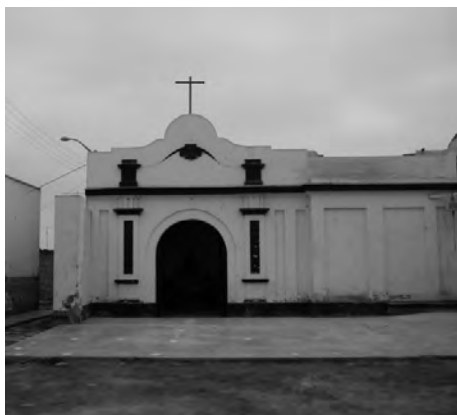
El templo de La Quebrada.
