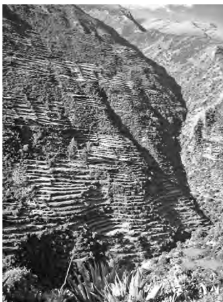
Foto 9: Vista panorámica del sector de andenes de Wishlaqaya, nótese la fuerte erosión del terreno y la impresionante obra de ingeniería para la construcción de los andenes.
