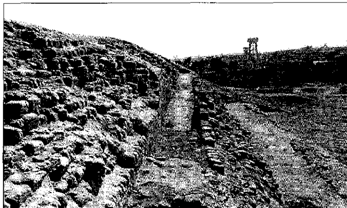
Vista desde el Este, del muro norte de la plataforma 2. Huaca San Marcos.
