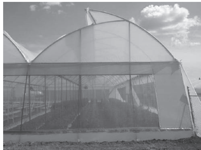
Figura 2. Invernadero de techo curvo.
