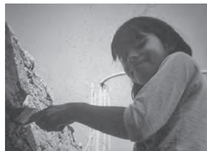
Figura 23. Muro C, área 5 aplicación de baba de choya.
