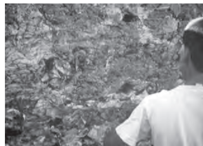
Figura 13. Área 1 del muro C pintada con baba de choya (xerófila Opuntia bigelovii ).
