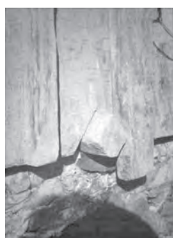
Figura 11. Apoyo del molde.
