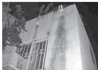
Figura 27. Aspecto exterior de la construcción.
