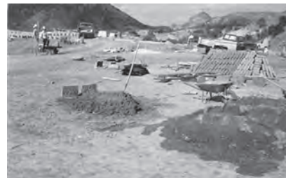
Figura 1. Casas en proceso de construcción con muros de adobe (AD) en Tarachi, Sonora, México.
