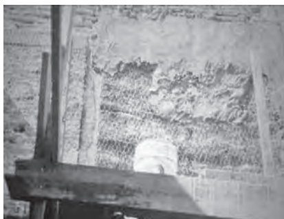
Figura 14. Muro A área 4.
