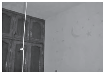
Figura 26. Aspecto interior de la construcción.
