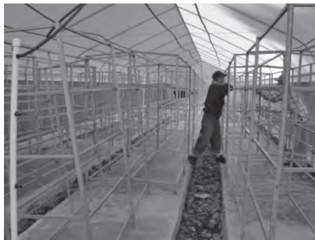
Figura 2. Vista de colocación de los sectores de riego.
