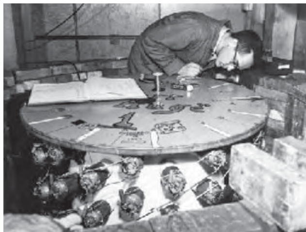
Figura 25. Primer sistema experimental de Reines y Cowan para detectar neutrinos (en realidad antineutrinos) provenientes de un reactor nuclear. En la fotografía Reines lo inspecciona.
