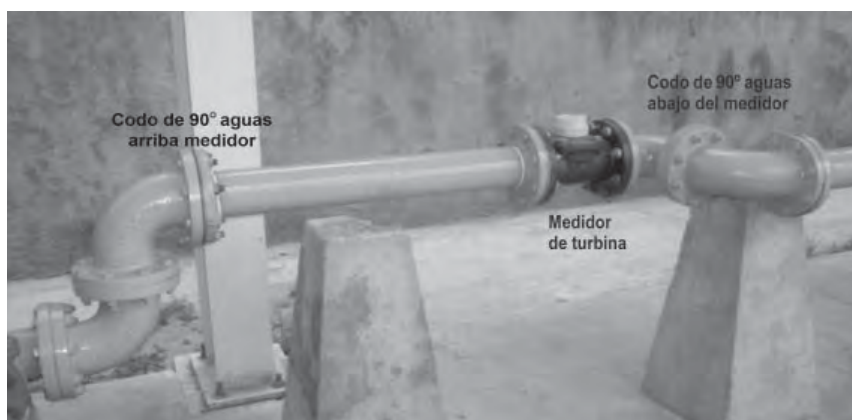
Figura 2. Vista del tramo de pruebas.
