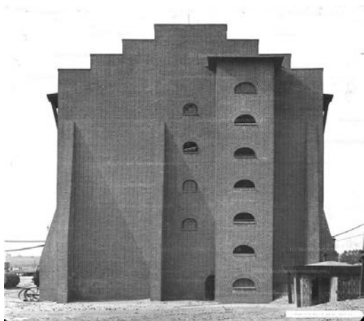
Poelzig. Fábrica de productos químicos, Luban 56
