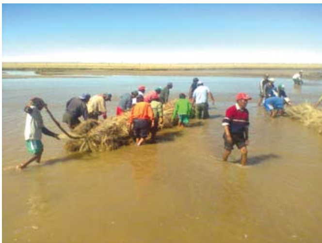
Trabajo comunal de mantenimiento de las obras hidráulicas
