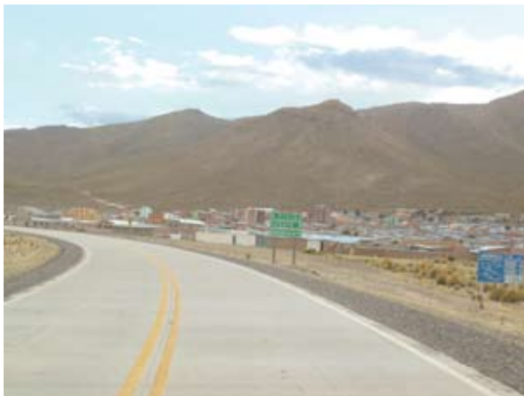
Carretera Oruro-Pisiga, con fondo del municipio de Huachacalla
