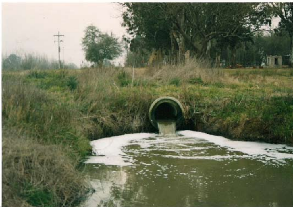
Figura 5. Efluente cloacal que descarga a la laguna de las Perdices.
