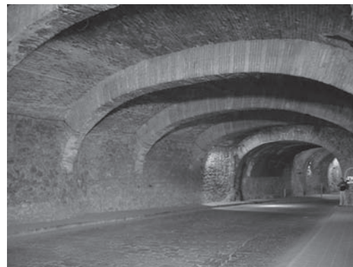
Figura 2: Calle Subterránea Miguel Hidalgo. Guanajuato, Gto., México.
